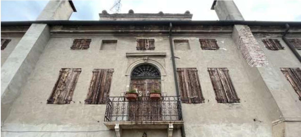
Particolare di macchia su cornice e frontone per presenza di umidità dovuta ad infiltrazione d'acqua. Incrostazione su cornice e frontone dovuta al deposito stratiforme di composto inorganico (inquinamento atmosferico) e di natura biologica (microrganismi autotrofi).
