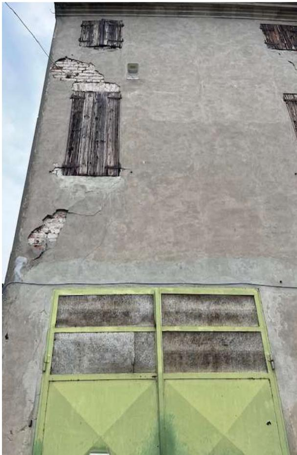
Particolare del degrado infissi in ferro (portone) e oscuri in legno
