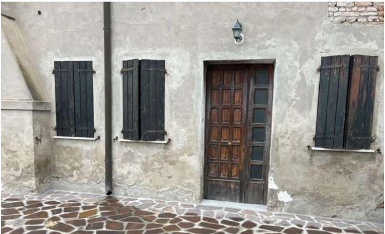
Particolare dell'umidità di risalita con distacco intonaco e polverizzazione del materiale sottoforma di polvere e granuli.
