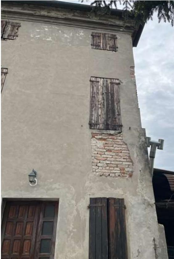
Particolare di esfoliazione con distacco e caduta degli strati d'intonaco
