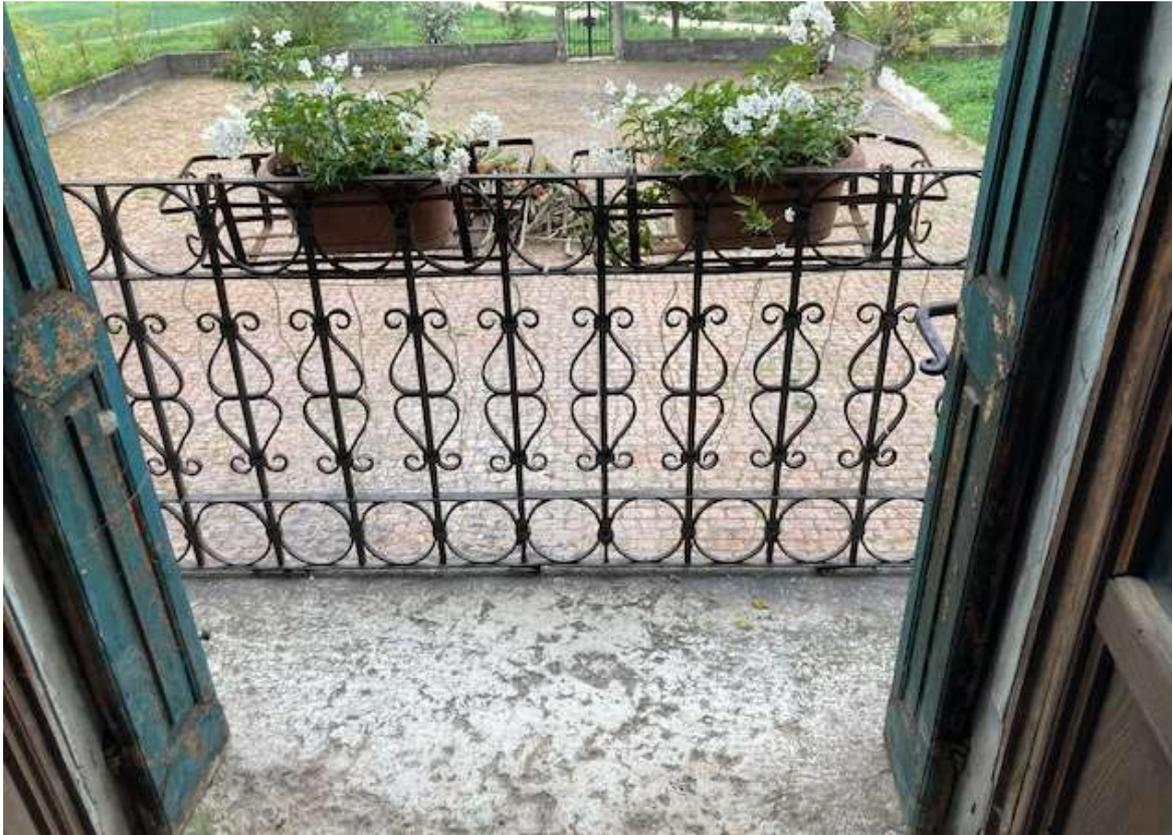
Particolare parapetto in ferro del piano nobile (presenza di ruggine)
