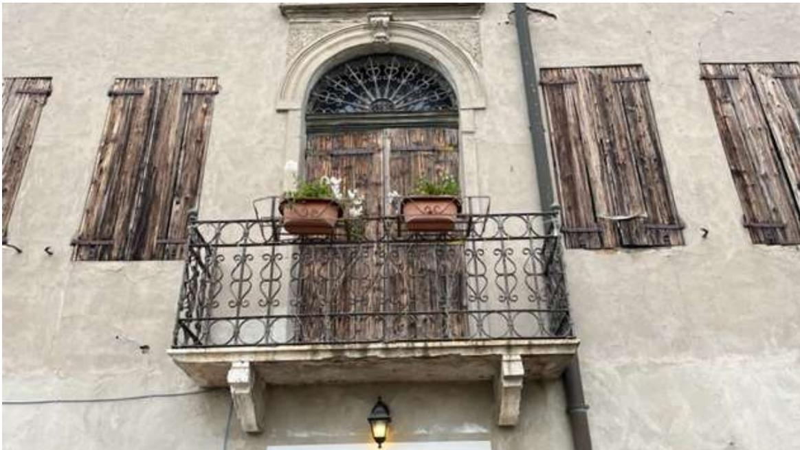
Particolare d'incrostazione alla balaustra marmorea, dovuta a deposito di sostanze d'inquinamento atmosferico e microrganismi autotrofi. Degrado del parapetto in ferro costituito dalla presenza di ruggine.
