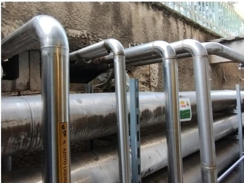
Particolare delle linee di distribuzione azoto liquido – cavedio piano interrato
