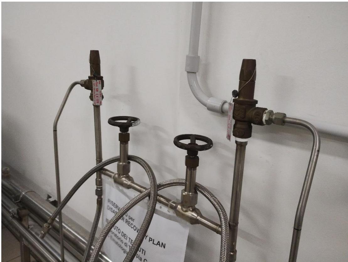
Particolare del sistema di adduzione dell'azoto liquido – piano interrato
