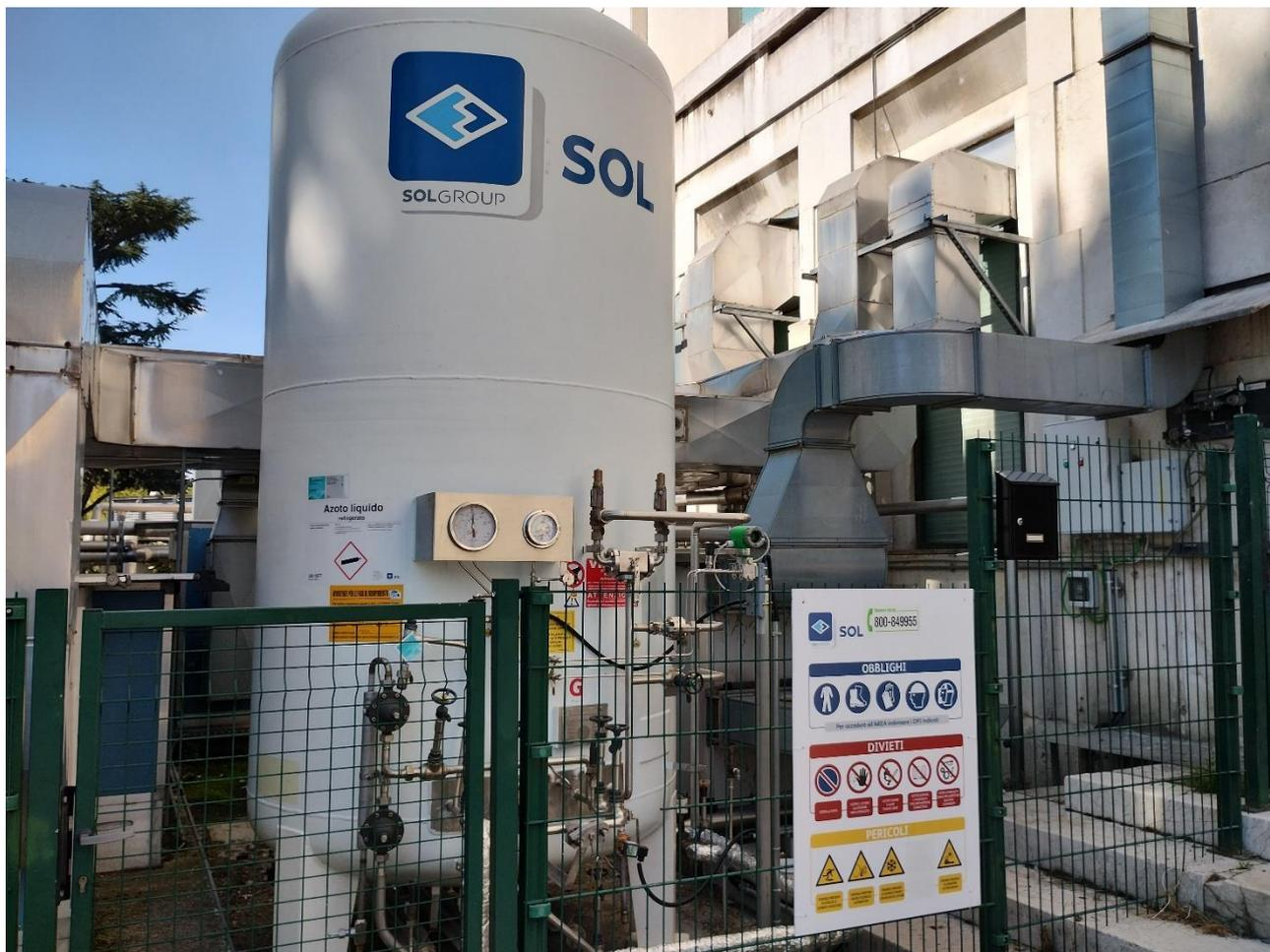
Fig. 7 – Centrale serbatoio Azoto liquido per linea piano terra locali PMA
