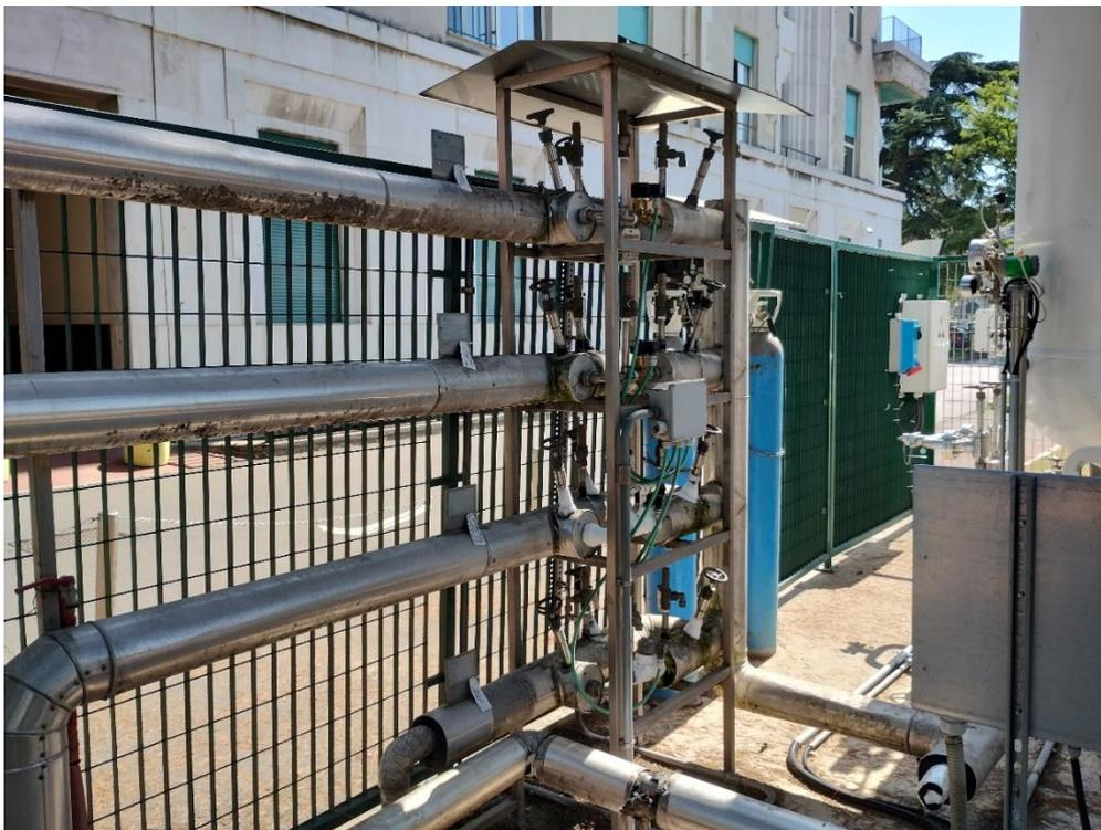
Centrale di stoccaggio azoto liquido e bombole CO2 – linee azoto liquido sale crio al piano interrato
