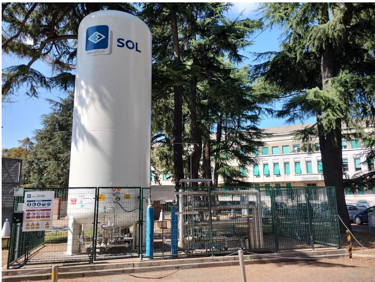
Fig. 6 – Centrale serbatoio Azoto liquido per linea piano interrato
